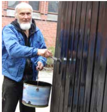
Søppelstativet trenger til oppussing!
